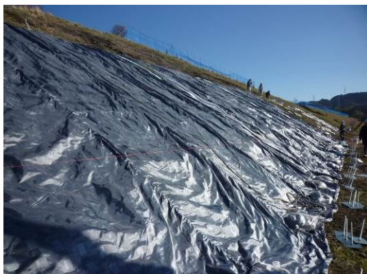
写真-1 PV ベースマット敷設
