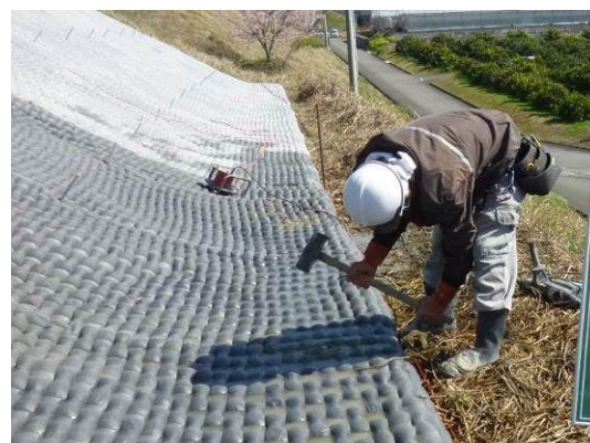
写真-4 鉄筋杭打設
