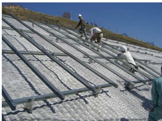
写真-5 架台組立・調整
