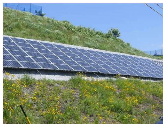
写真-8 施工完了
