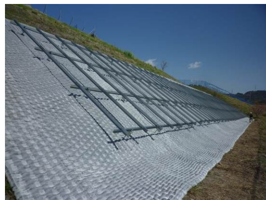
写真-6 架台組立完了
