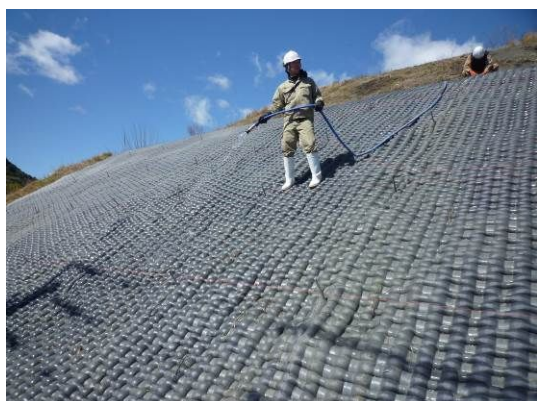
写真-3 仕上げ（マット洗浄）
