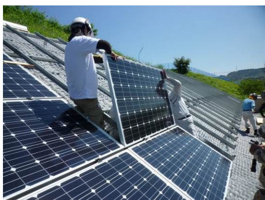
写真-7 太陽電池モジュール設置
