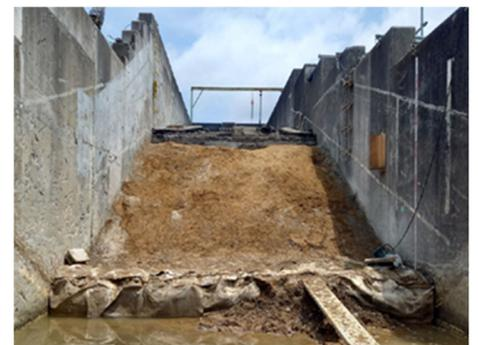
写真-4 被覆工撤去後の堤体状況
