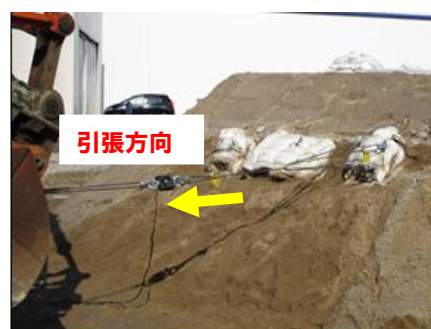
写真-4 引抜き試験状況
