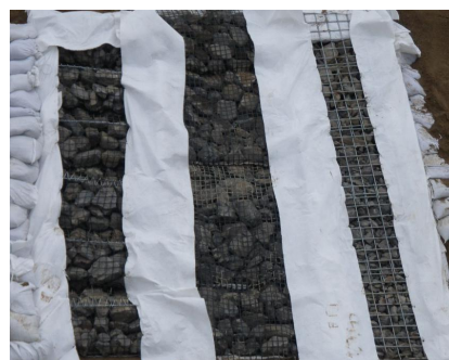
写真-2 ジオテキスタイルの巻き込み状況
