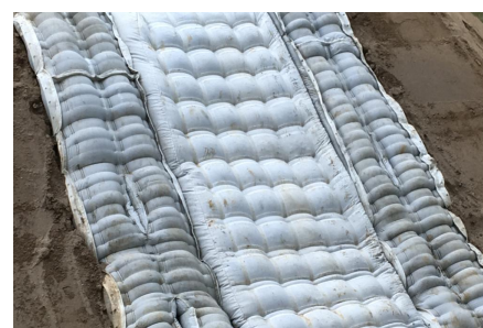
写真-3 全面の布製型枠
