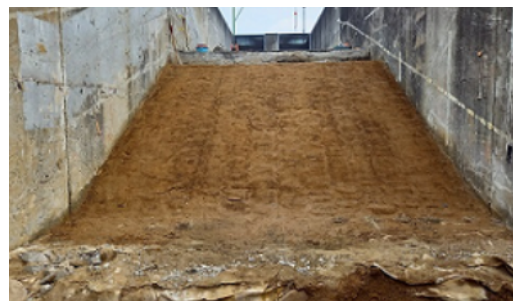
写真-17 ケース 2 撤去後の堤体状況
