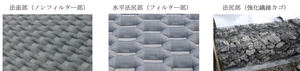
写真-3 モルタル被覆タイプの各部位写真
