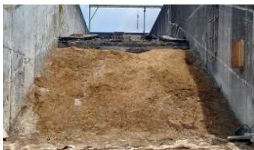
写真-16 ケース 1 撤去後の堤体状況
