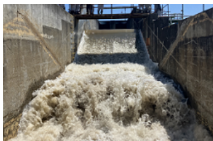
写真-9 越水実験状況 2
