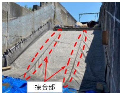
写真-7 透気防水シート接合部
