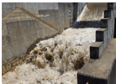
写真-8 越流実験状況 1
