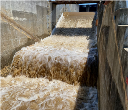
写真-2 越水実験状況
