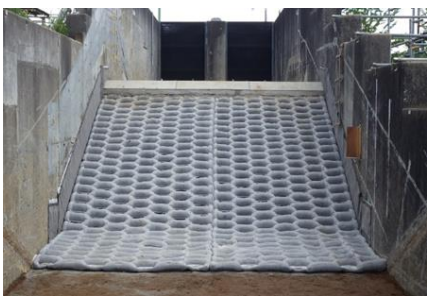
図-6 越水実験状況（越水前）
