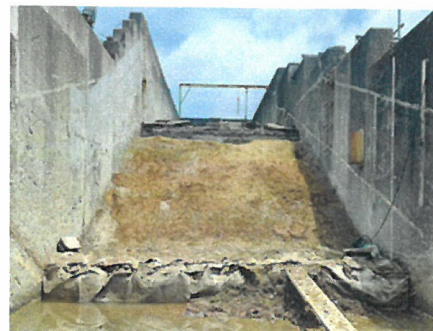
写真-4 被覆工撤去後の堤体状況
