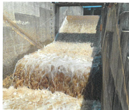
写真-2 越水実験状況
