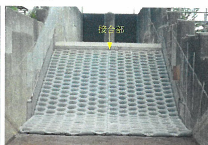
図-3 越流対策型布製型枠 接合位置
