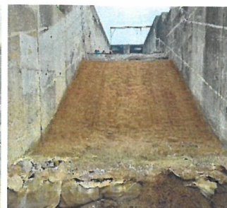
図-8 被覆工撤去後の状況
