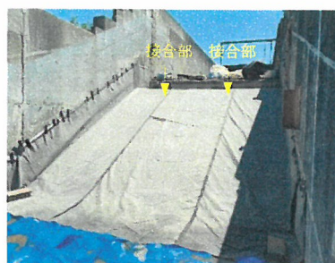
図-2 透気防水シート接合位置
