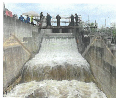
図-5 越水実験の状況
